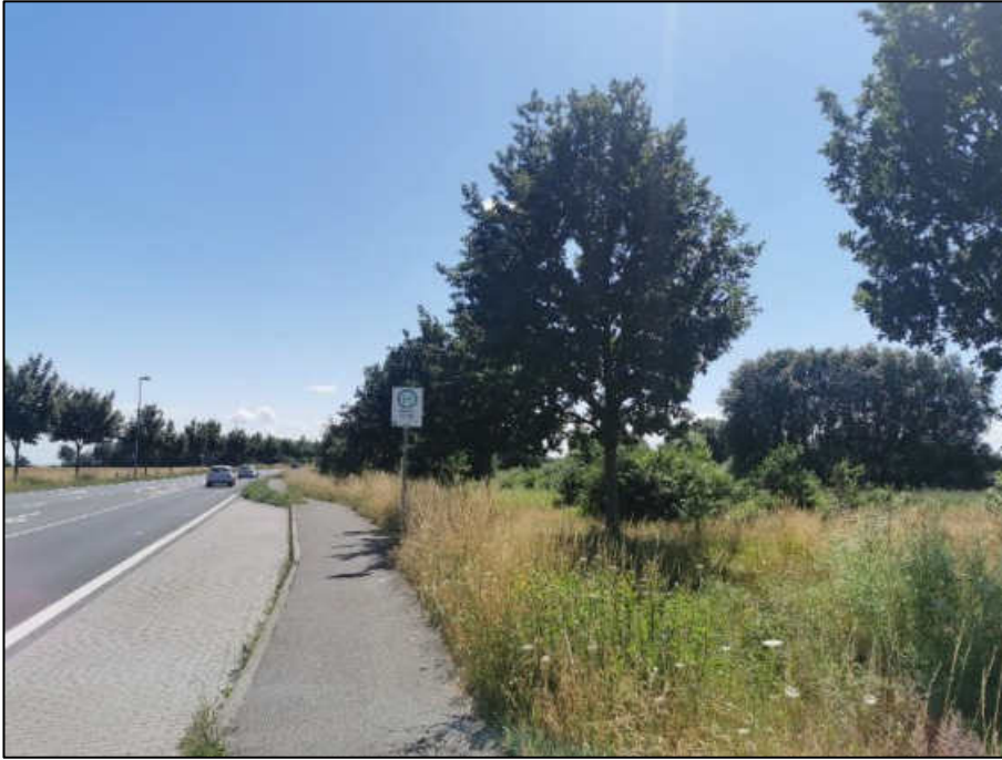
Abb. 15: Landesstraße in Richtung Süden (Foto 07.07.2021).
