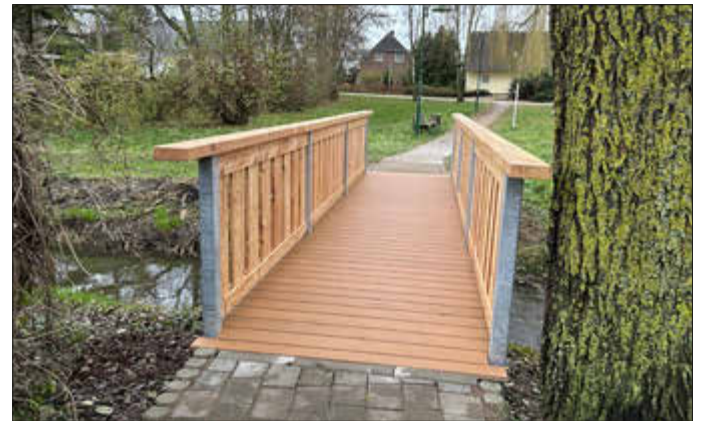
Neue Brücke fertig
