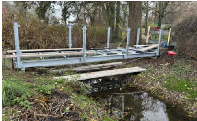
Grundkonstruktion Brücke Neu
