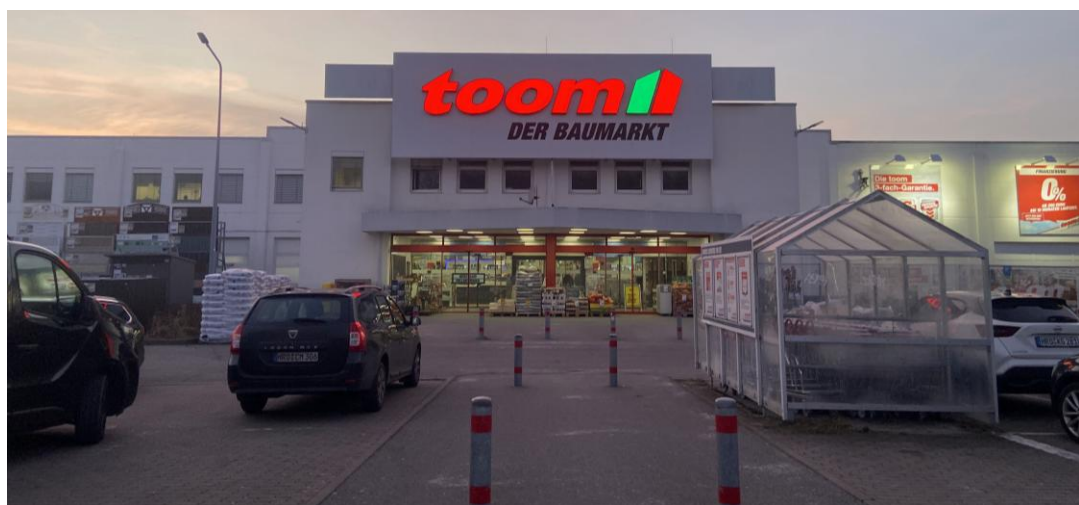
Abbildung 14: Toom-Baumarkt am FMS Trelleborger Straße in Rostock
