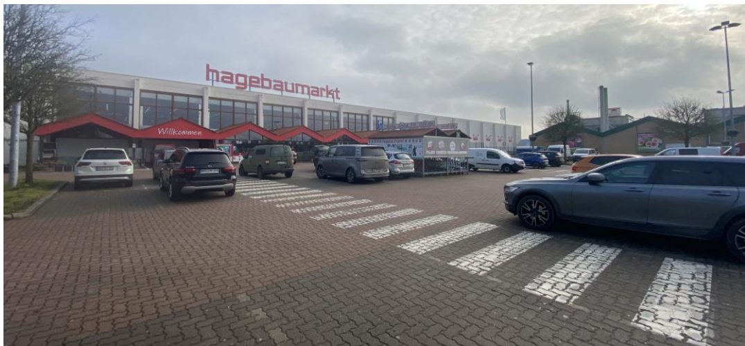
Abbildung 16: Hagebaumarkt am FMS Rövershäger Chaussee in Rostock
