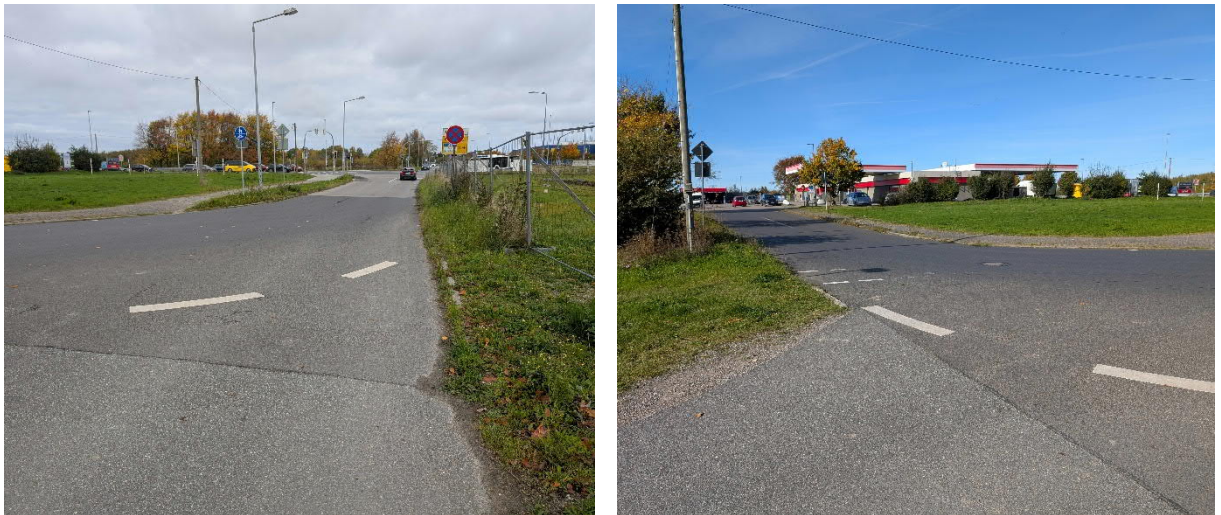
Abb. 2 Messestraße, Blick Richtung Knotenpunkt an der B 105 (links) und Einmündung Esso Tankstelle (rechts)
