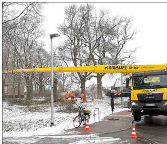
Baumarbeiten in Wilsen mit großer Arbeitsbühne
