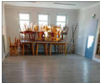
Neuer Fußboden im Vereinshaus
