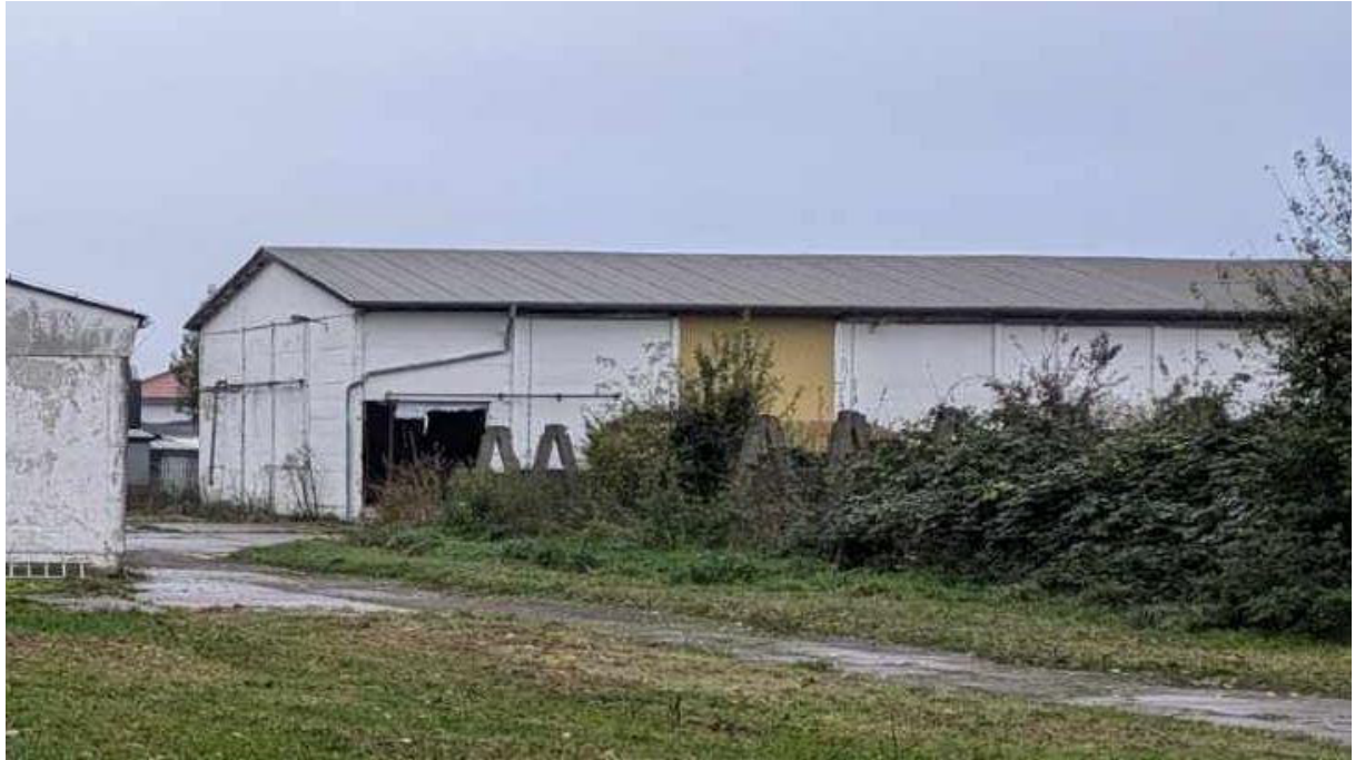
Foto 4-2: Nordansicht von Gebäude 1.
