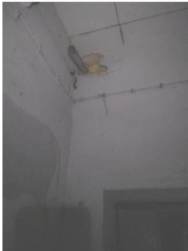
Foto 4-3: Quartier Braunes Langohr im Durchgang zwischen Gebäude 2 und 3.
