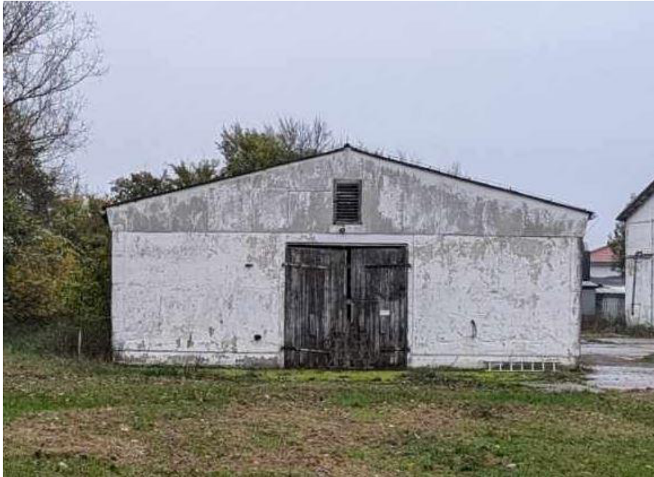
Foto 4-6: Gebäude 5 – Einflugmöglichkeiten an der Holztür und im darüber liegenden mit Lamellen verkleideten offenem Fensterbereich.
