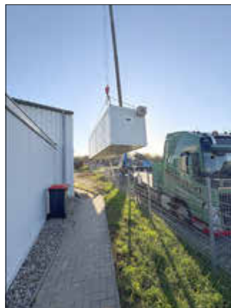
Errichtung der Raummodulanlage als Sozialtrakt
